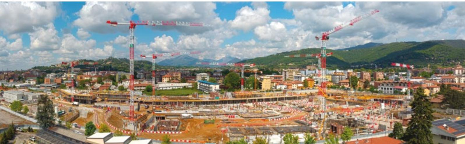
Alla crescita delle componenti strutturali è corrisposta in questi mesi la posa dei corpi scala prefabbricati e delle prime predisposizioni per le facciate Gualini. A breve verranno invece installati i primi bagni prefabbricati, completi nelle finiture ed esempio dell'importanza della prefabbricazione nell'industrializzazione dei processi costruttivi promossa dal gruppo COSTIM e applicato a Chorus Life.
